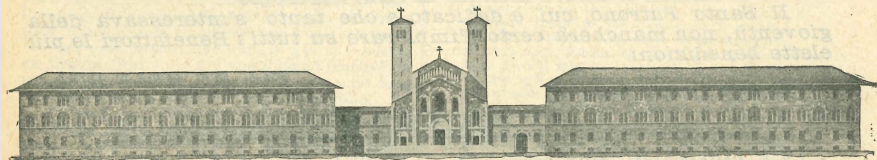
Parte già costrutta.
